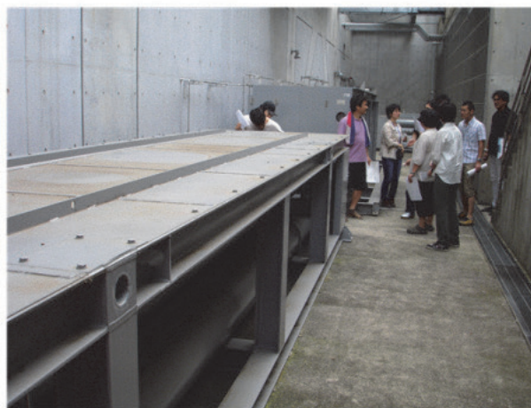
図 2 長尺ボンベ(手前)増設分 6 本、(奥)既設分のうち 9 本。残る 1 系統は屋内に設置。
