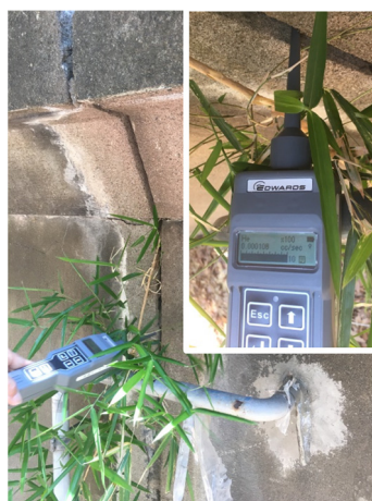
図3 加圧試験 埋設配管からヘリウムガス検知 (2019.05.24)
