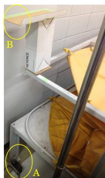
図5 ガスバック レベルセンサ(円内 A) と反射板(円内 B)
