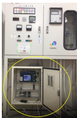
図3 新設した制御盤 (円内)と既存の 制御盤
