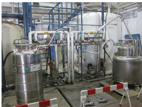
図 1. 産総研の液体ヘリウム貯槽と汲み出し場
