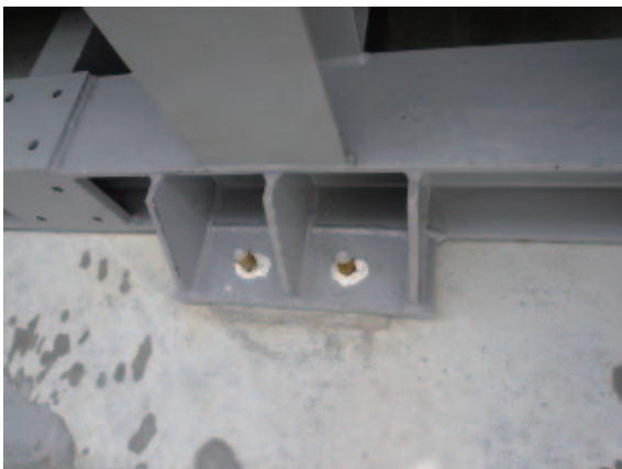
(上)図 1. 長尺ポンベ下段と地面を留めるボルト部分を防水・防錆のためシールした
