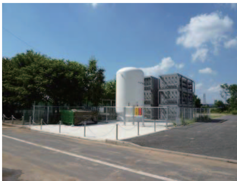
図 4. 工事終了後の写真。今回設置されたのは写真右奥の長尺ボンベ 3 段組 45 本である。左側のカバーで覆われた長尺ボンベおよび手前の白いバッファタンクは 3 月頃に設置された。後の工事でエリア内を覆う屋根が設置される予定である。
