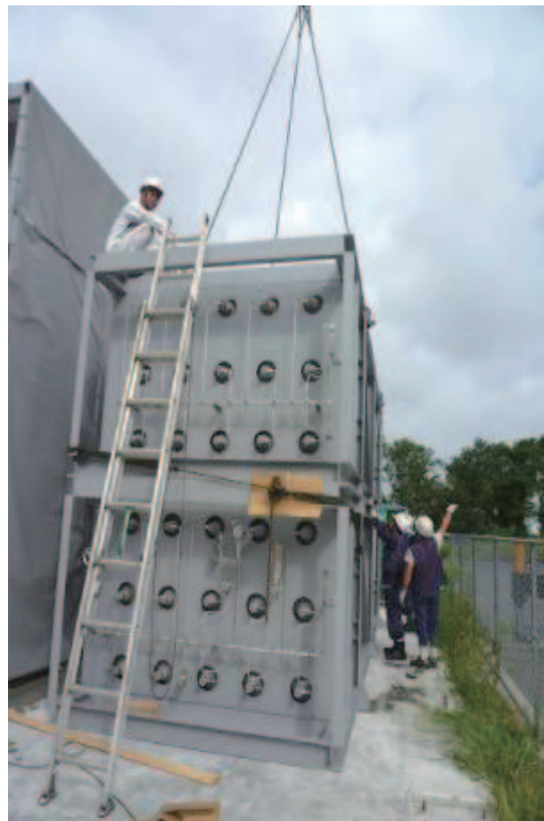
(右) 図 2. 長尺ポンベ 3 段組の内、下段と中段を設置し、下段・中段の位置調整を行っている。中段から下段にかけて中央で結んでいる黒い紐に見える部分がチェーン荷締機である
