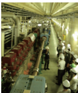
図3. トンネル内の様子
