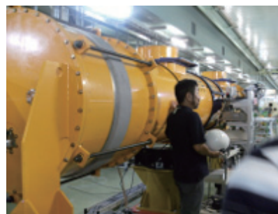
図4. 超伝導空洞用クライオスタット
