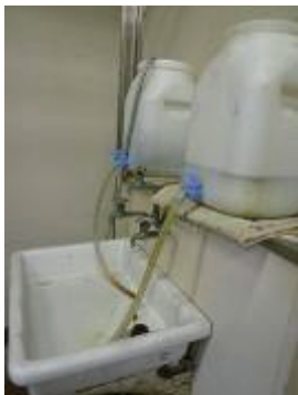
図 7 廃液 (油水混同)
