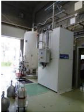
図3. 液体窒素貯槽(左)と窒素液化機(右)
