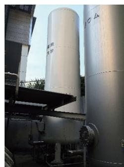
図5 液化窒素貯蔵設備
