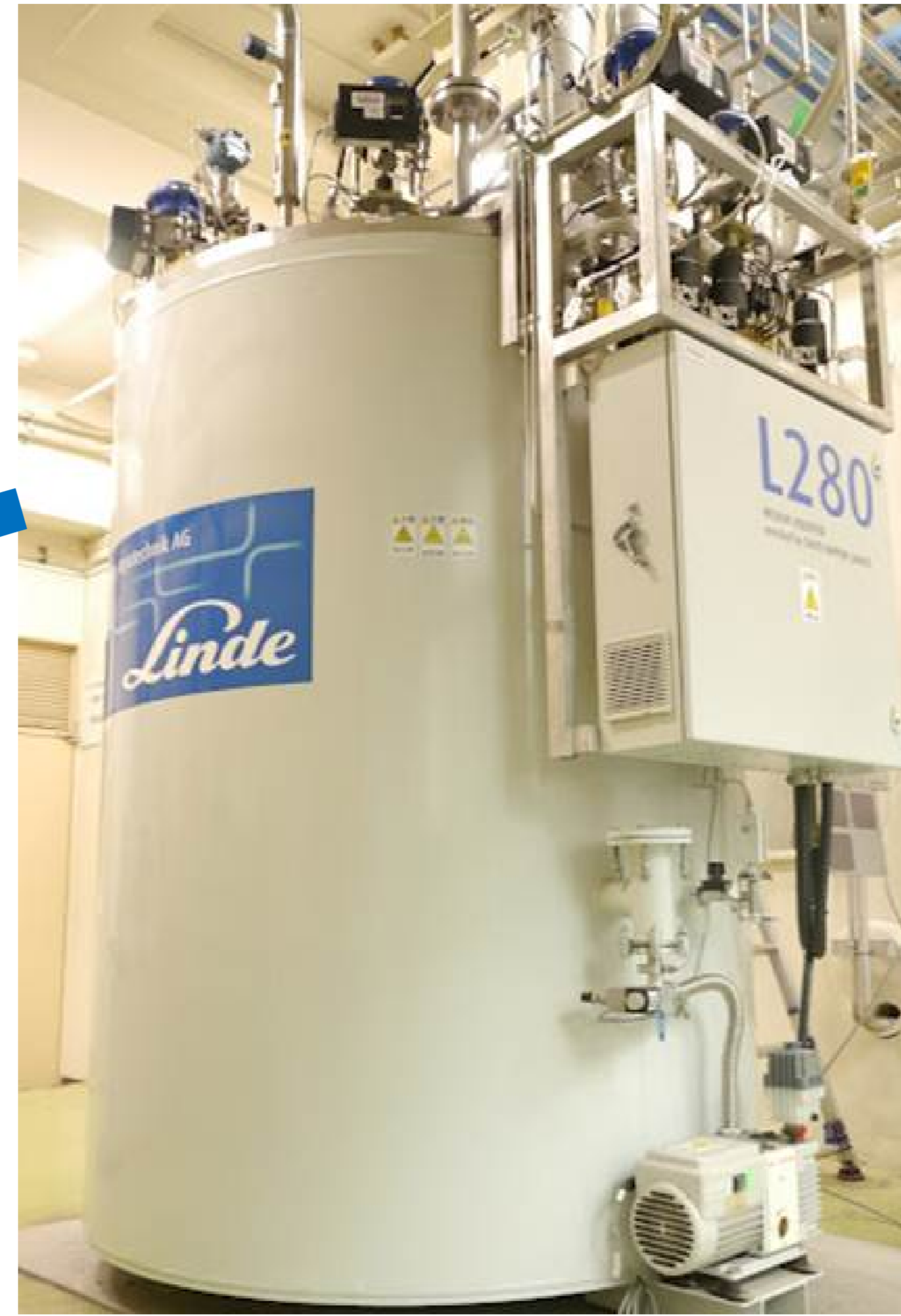
ヘリウム液化機 Linde社製 L280型 液化量 200ℓ/h以上 (純ヘリウムガス使用時)
