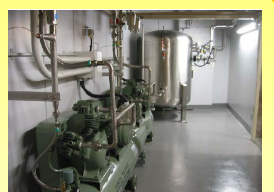
薬学部内サブセンター ・圧縮機 型式:5.5P-9.5G型(日立) ・サージタンク 容量:1.5m 3 ・ガスバック 容量:6m 3
