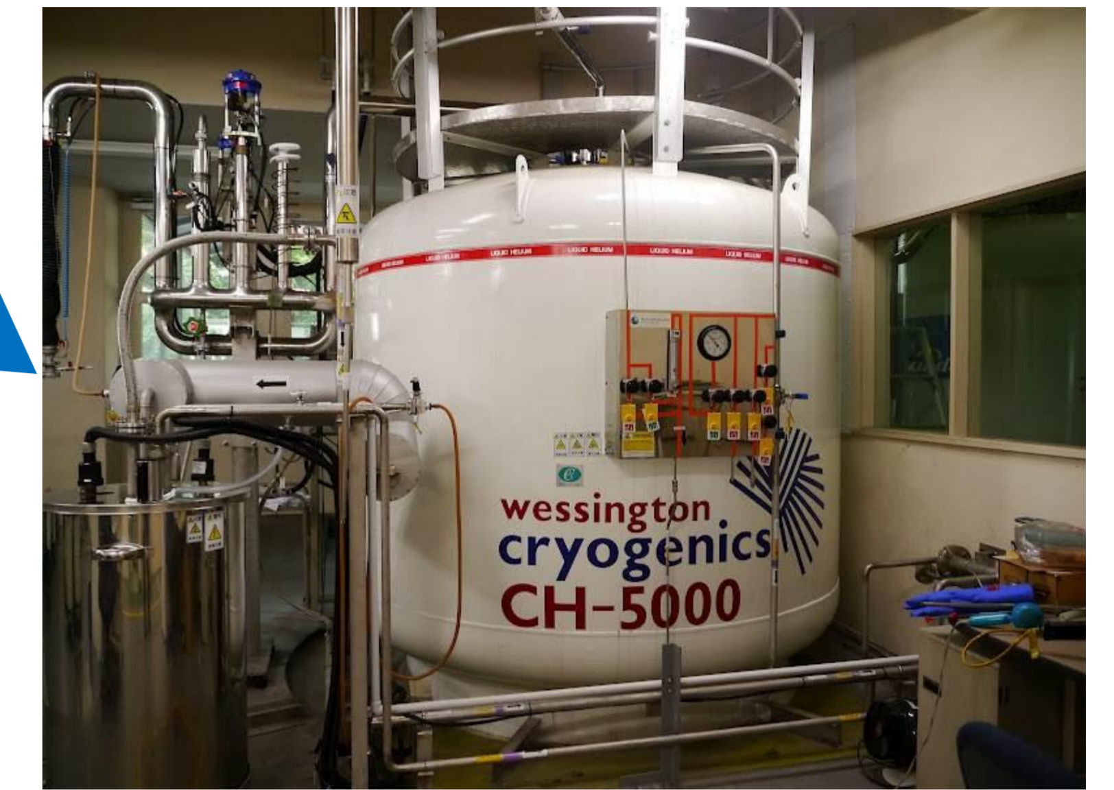
液体ヘリウム貯槽 Wessington CH-5000 貯槽容量 5000ℓ
