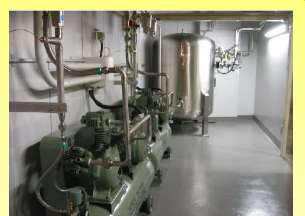
薬学部内サブセンター ・圧縮機 型式:5.5P-9.5G型(日立) ・サージタンク 容量:1.5m 3 ・ガスバック 容量:6m 3
