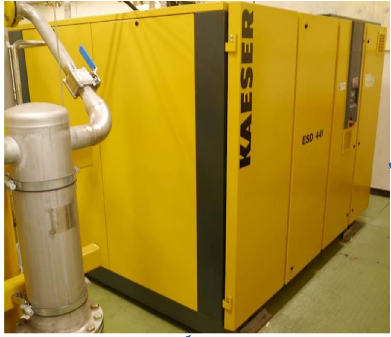
液化用圧縮機 KAESER社製 ESD441 吐出圧0.95MPa
