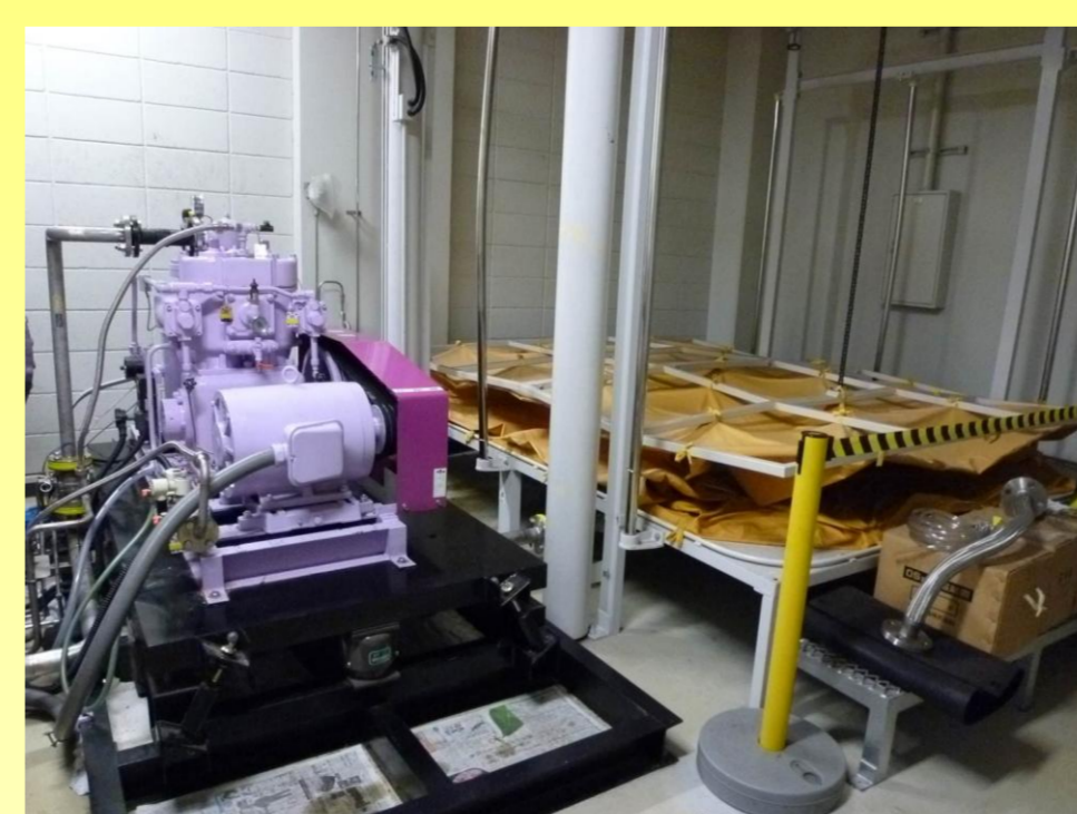
理学部内サブセンター (理学部新1号館) ・圧縮機 型式:5WMC(東亜潜水機) ・サージタンク 容量:2m 3 ・ガスバック 容量:15m 3
