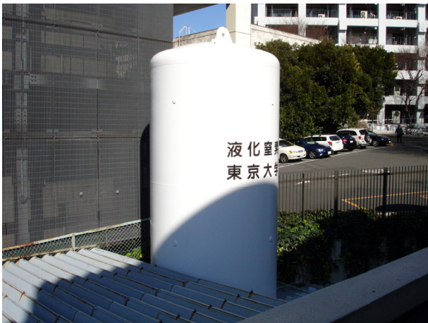
図1. 液体窒素コールドエバポレータ(CE) 学内供給用 17,000 L
