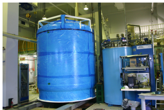
図 1 10,000L 貯槽 搬入の様子
