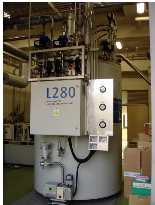
図3. ヘリウム液化機 Linde 社製 L280 2008年度導入、液化能力200 L/hour 初代～現在の四代目は全て膨張タービン方式
